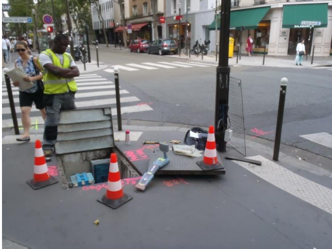
Figure 5 : Photo de chantier avec matériel de DEM
